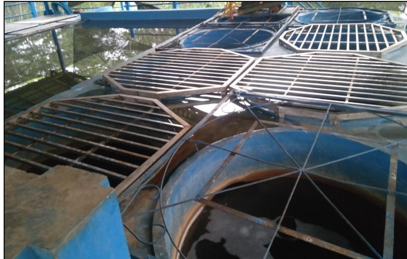
Gambar 4.29. Bak Flokulasi
