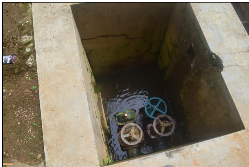
Gambar 4.19. Wash Out Sedimentasi Untuk Pengurasan
