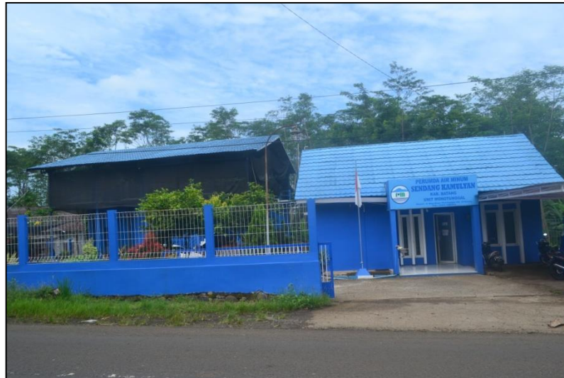
Gambar 4.16. Unit Pengolah / IPA (Instalasi Pengolahan Air) Wonotunggal
